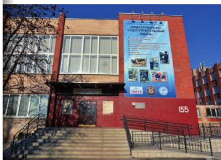
Парадный вход в лицей после ремонта
