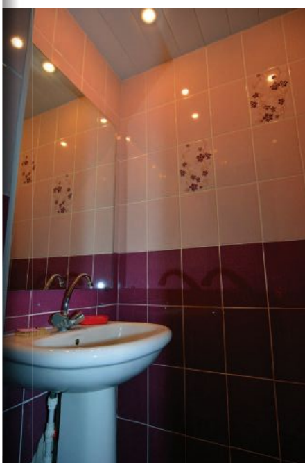
Туалетная комната после ремонта в детском саду № 50
