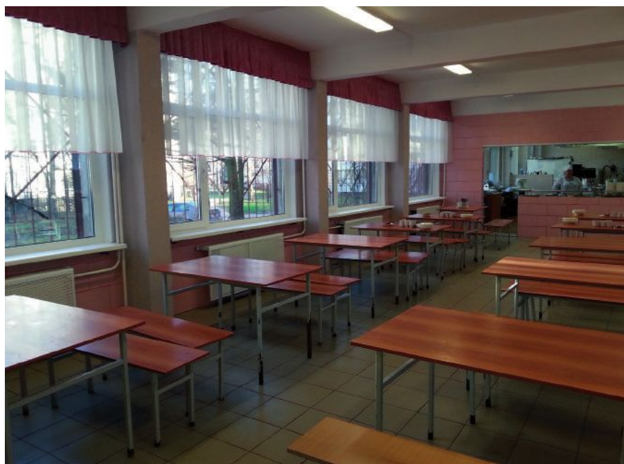
Столовая школы № 283 после косметического ремонта
