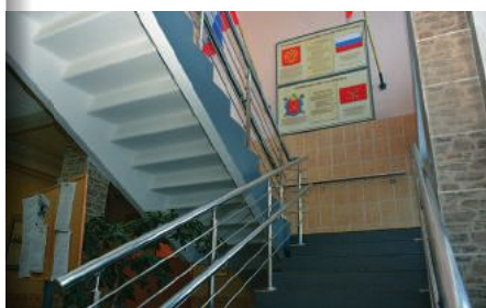
Отремонтированные лестничные пролеты в школе № 251
