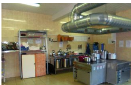
Пищеблок детского сада № 43 после ремонта
