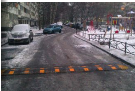
Установленная искусственная дорожная неровность на ул. Генерала Симоняка д. 23
