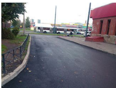
Проезд между д. 98 и 78, корп. 2 по пр. Ветеранов после ремонта асфальтобетонного покрытия
